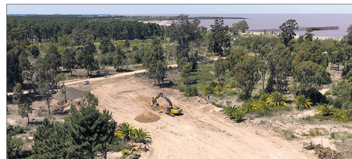
INICIO. En las últimas semanas comenzaron las obras de infraestructura.
