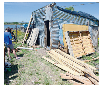
Una obra en Santa Catalina.
